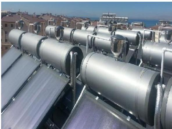
Figura 19. Calefontes solares en Turquía sobre techos de edificios
