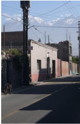
Figura 70. Vivienda antes del pintado.
