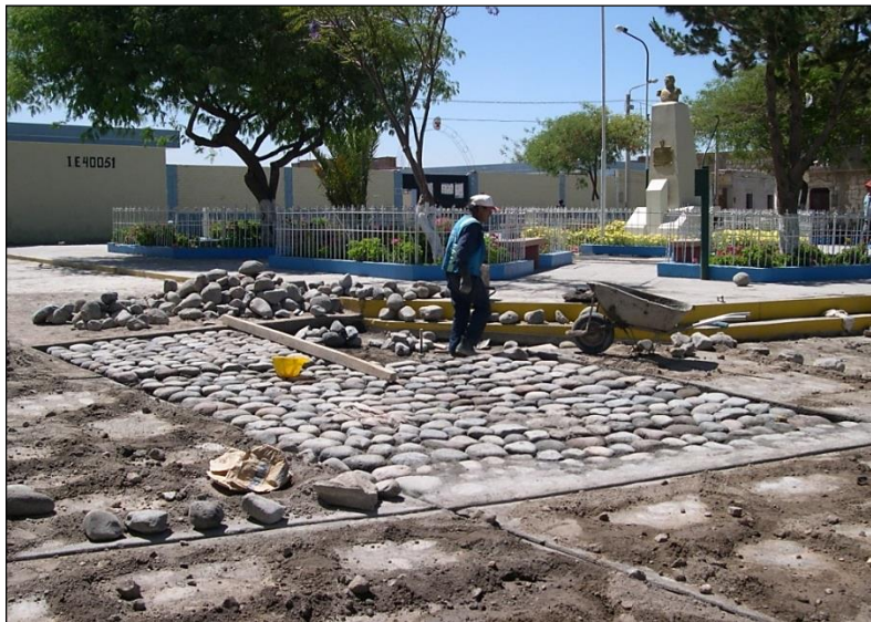
Figura 64. Trabajos de mejoramiento de vía.
