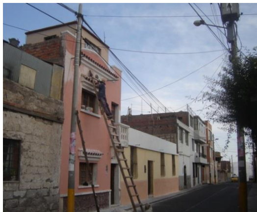
Figura 67. Pintado casi terminado
