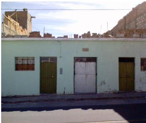
Figura 72. Vivienda antes del pintado.
