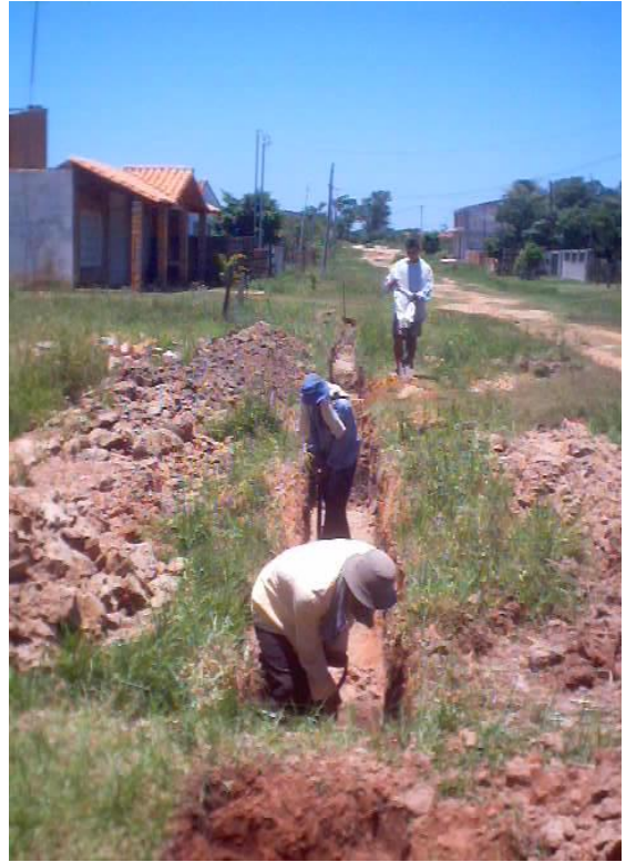
Foto N° 7. Ejecución de obras del alcantarillado sanitario. 2004
