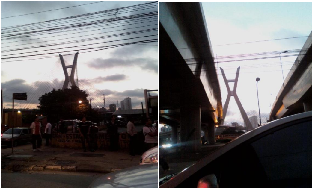
Puente Estaiada y obras viales de la Operación Urbana Consorciada Água Espraiada.(SP)
